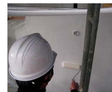
ローラー施工
