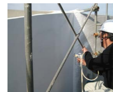
吹き付け施工
